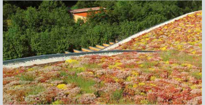
Abb. 5/1: Dach mit Extensiv-Begrünung
