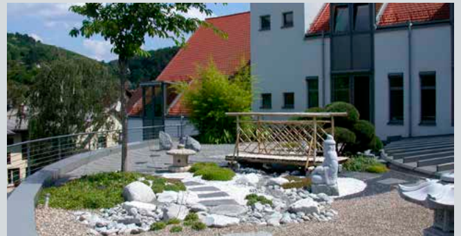
Abb. 5/2: Dachterrasse mit Intensiv-Begrünung
